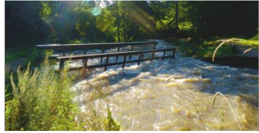
0Det voldsomme regnvejr har ødelagt brinker og broer i det naturskønne område i Egebjerg. Foto: Horsens Kommune
