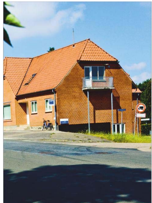
Asfalten skal væk og erstattes med fliser til fortovet. Og så skal der bl.a. laves en trappe på skråningen her ud mod Grusdalsvej. FOTO: MORTEN PAPE
